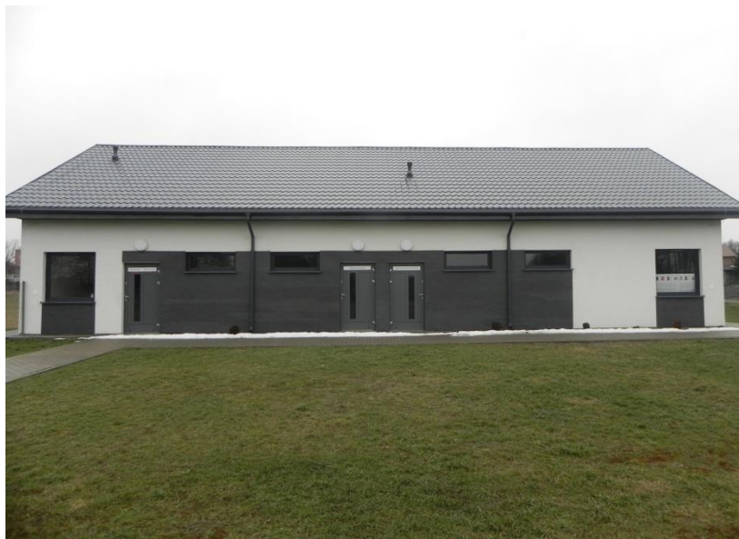
Fot. 16 Zaplecze sanitarno-szatniowe przy boisku sportowym w Michowie.
